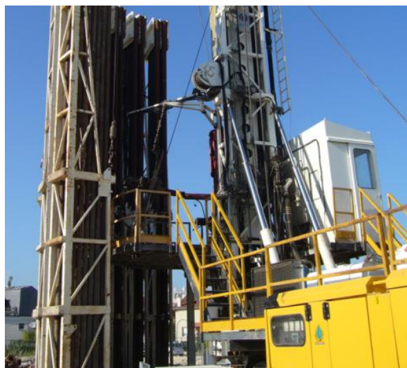
Forage des puits géothermiques © Fort d'Issy.info
