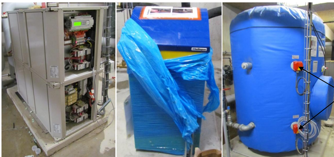
A gauche : PAC chauffage ; Milieu : PAC ECS ; A droite : Ballon ECS
